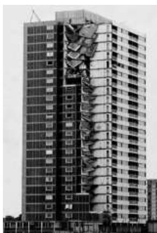
شکل ۱- فروپاشی ساختمان رونان پوینت به دلیل انفجار گاز در طبقه هجدهم
